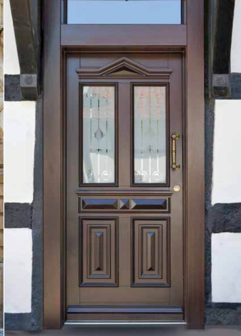
Üppige Zierleisten fassen bei dieser Rahmentür die Füllungen mit Diamantstäben ein
